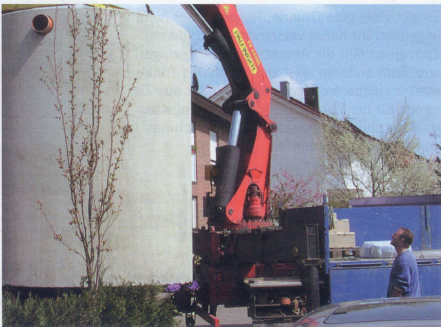
In den unterirdischen Regenspeicher aus Beton-Fertigteilen ist ein Filterkorb integriert. Zulauf und Ablauf führen durch die Behälterwand und lassen sich ohne zusätzliche Abdichtungen stecken.
